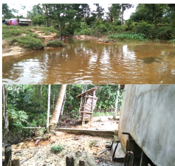
Gambar 2. Infrastruktur Jalan menuju Desa Bengawan Ampar
