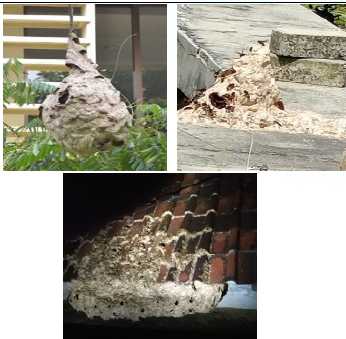
Gambar 4.3. Sarang V. affinis yang menggantung pada ranting pohon (kiri) dan menempel pada bangunan (tengah dan kanan). Foto: Sih Kahono
