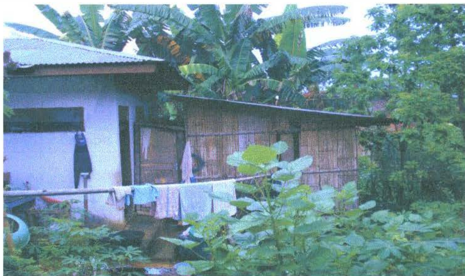
Gambar 3. Bagian belakang rumah dinas kepala puskesmas Wae Codi (bangunan tambahan tidak permanen adalah dapur) Gambar di ambil pada tgl 6 Desember 2011.
